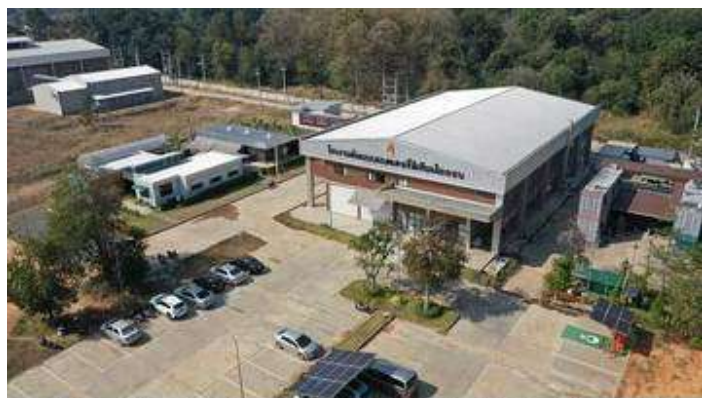
コンケン大学の研究所の建屋。この中にバッテリー材料、セルの製造ラインがある（昭和興産タイランド提供）
